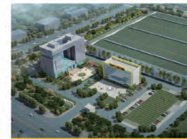
Nhà máy mới của Tập đoàn QGM tại Trung Quốc
